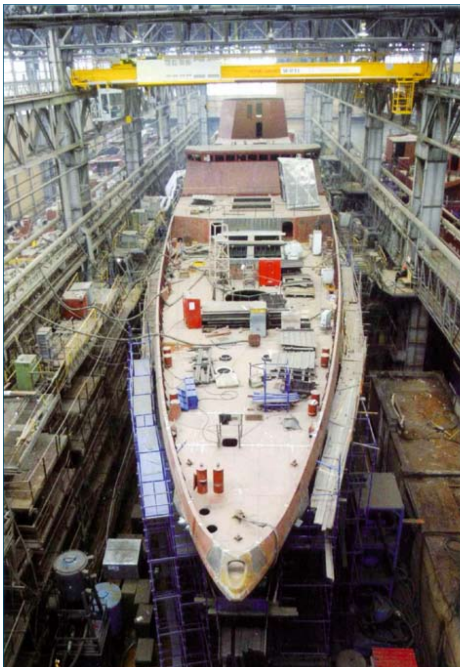
↑ Jednostka w czasie ostatnich prac przed wytoczeniem z hali. Na tym zdjęciu widać inny kształt masztu, niż znany z modelu eksportowego proj. 22356, na którym mają być umieszczone anteny ścienne radaru.
