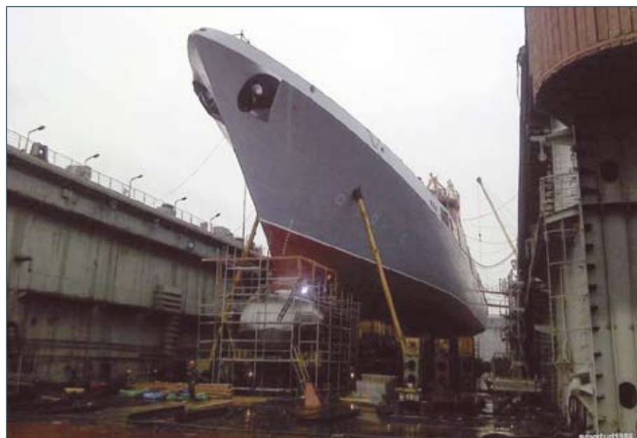
↳ Montaż stalowego opływnika stacji hydrolokacyjnej Zarja -ME-03.
